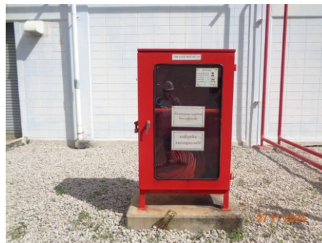
ภาพที่ 2.2-53 หัวต่อสายฉีดน้ำดับเพลิง
