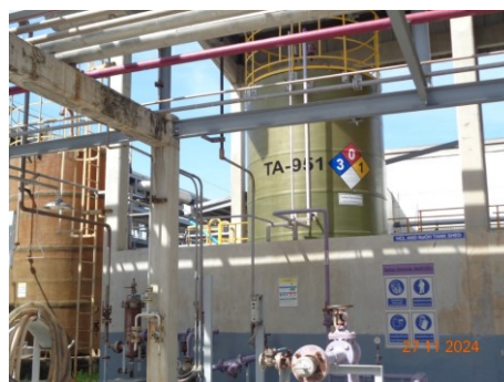
ภาพที่ 2.2-37 ถังเก็บโซเดียมไฮดรอกไซด์ พร้อมคันคอนกรีต
