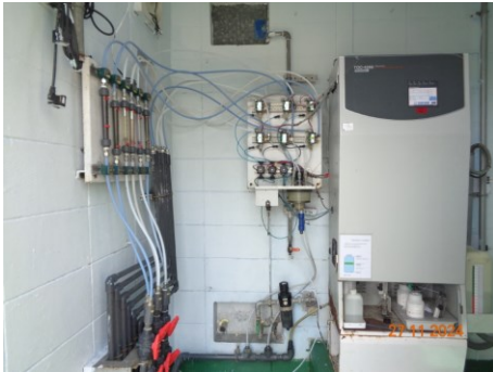
ภาพที่ 2.2-11 เครื่องตรวจวัด คุณภาพน้ำทิ้งอัตโนมัติ บริเวณบ่อกักน้ำทิ้ง
