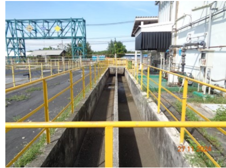
ภาพที่ 2.2-10 ระบบระบายน้ำฝน
