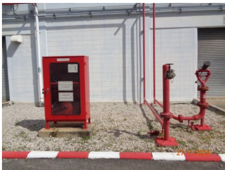
ภาพที่ 2.2-52 ท่อน้ำดับเพลิงและหัวต่อ ทางน้ำเข้าของหัวดับเพลิงกับระบบท่อน้ำ
