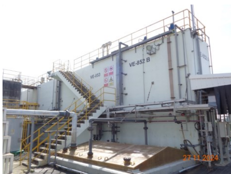
ภาพที่ 2.2-7 ระบบบำบัดน้ำเสีย ทางชีวภาพ (UASB)
