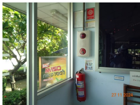
ภาพที่ 2.2-55 ถังดับเพลิงชนิดมือถือ และป้ายบอกตำแหน่ง
