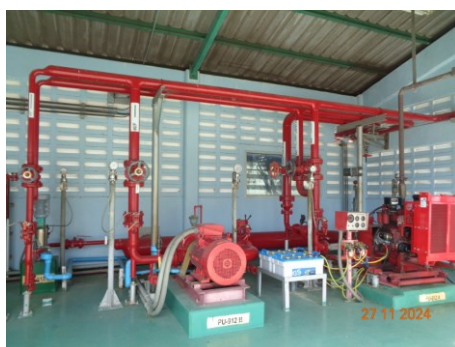
ภาพที่ 2.2-56 ปั๊มส่งน้ำชนิดเครื่องดีเซล
