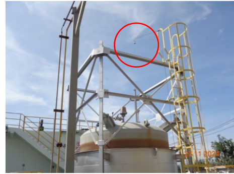
ภาพที่ 2.2-2 อุปกรณ์ตรวจวัดก๊าซมีเทน บริเวณถังปฏิกริยา UASB
