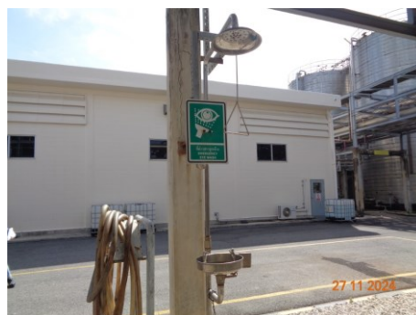
ภาพที่ 2.2-35 อ่างล้างตาและฝักบัว ชำระร่างกายฉุกเฉิน
