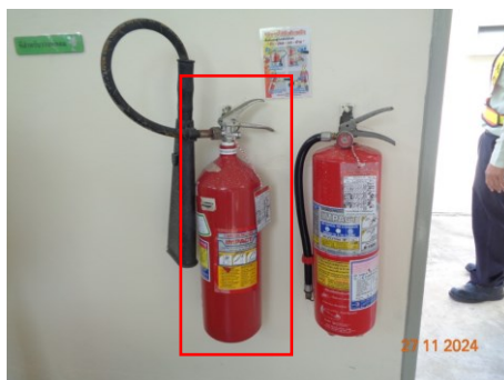
ภาพที่ 2.2-51 Fire extinguisher ชนิด Carbon dioxide
